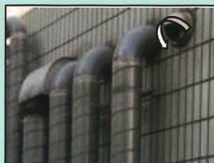
排気ダクト周り
